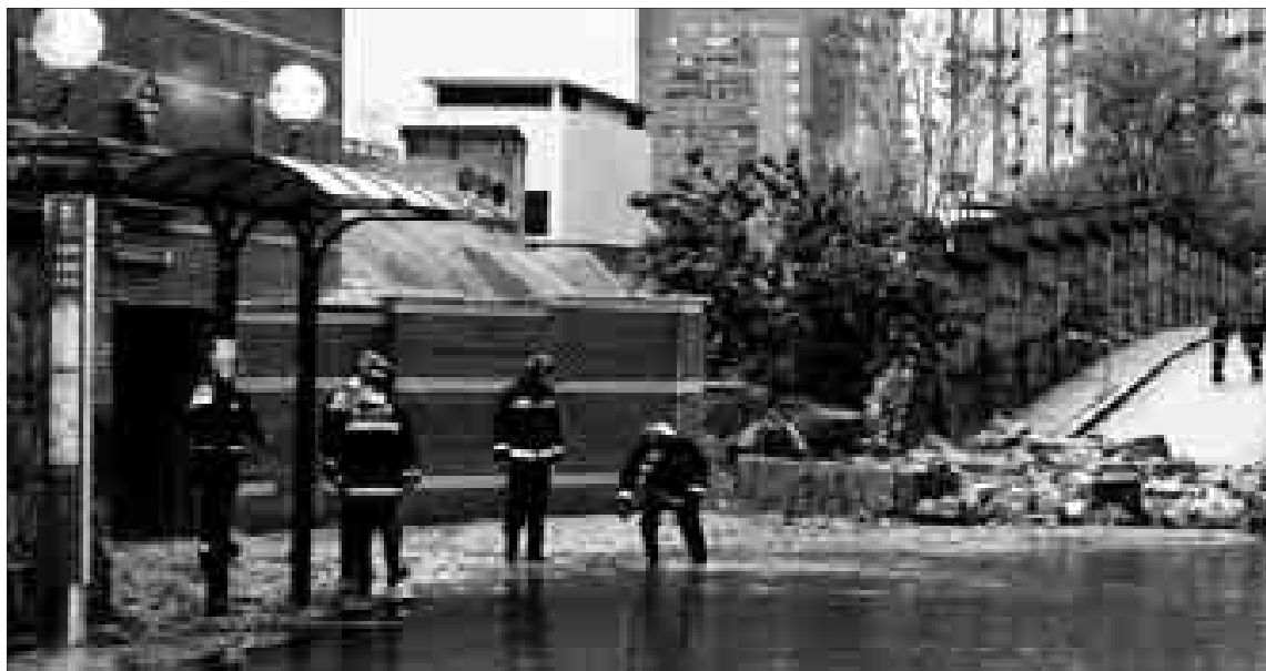
Los Bomberos achican agua junto a una boca de Metro y quitan restos del muro que se cayó en la calle Bambú. / JAIME VILLANUEVA
