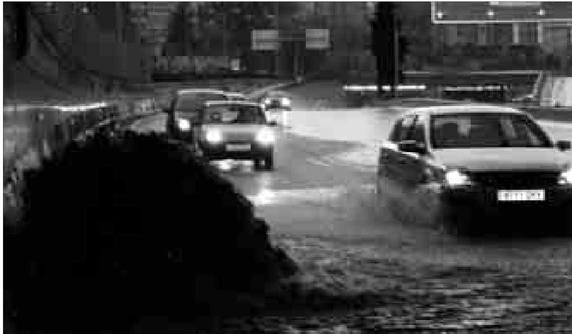
El agua sale a borbotones e inunda toda la calzada de la M-30, ayer, cerca de la avenida de los Pinos. / P. HERRAIZ
