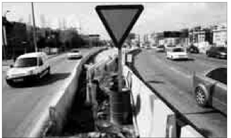
Señal de ceda el paso instalada chapuceramente en un barril. / ANTONIO HEREDIA
