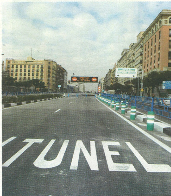
Túnel de Cuatro Caminos. Termina con la frontera entre dos distritos.
