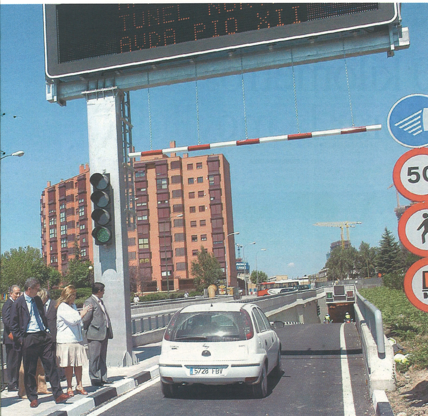
La inauguración del túnel Norte de Pío XII se produjo con casi un año de adelanto sobre los plazos previstos inicialmente.
