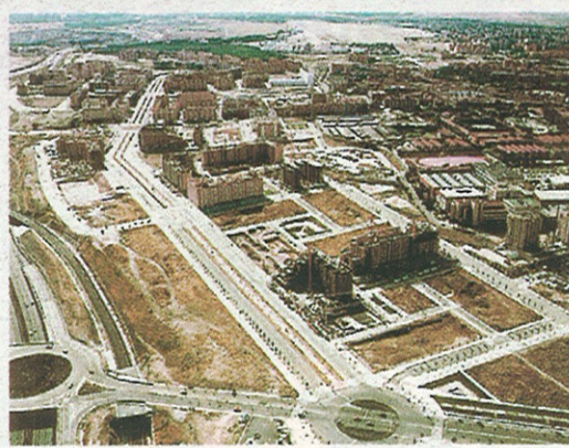
Ejemplo de transformación urbana. La avenida de la Aviación presta servicio a los barrios de Las Águilas, Cuatro Vientos, Buenavista y el Ensanche de Carabanchel (en la foto de abajo), en los que residen más de 30.000 ciudadanos. Su remodelación constituye uno de los ejemplos más claros de transformación urbana.
