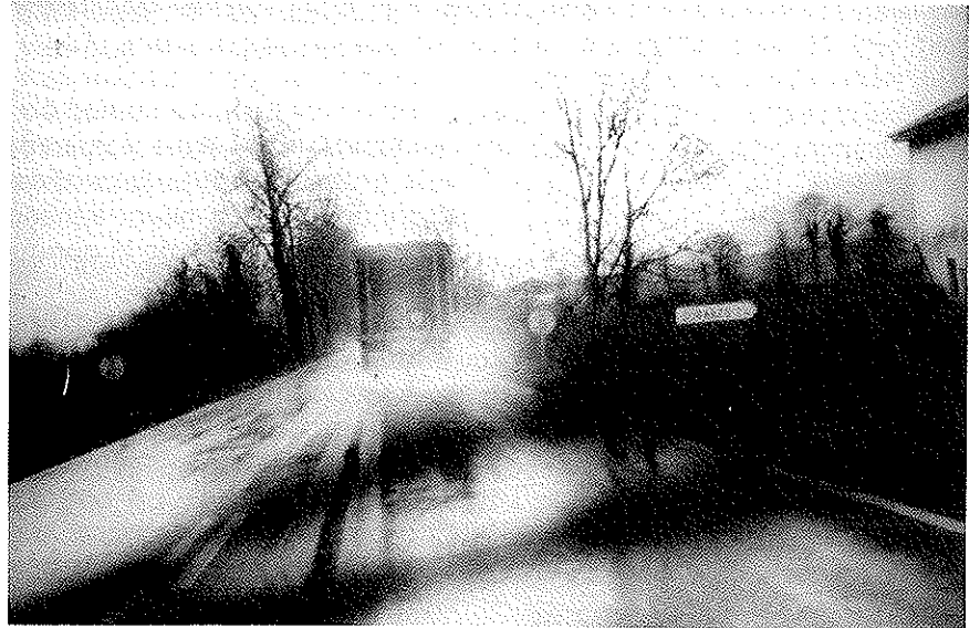
Fig. 6 Proyección de agua por el paso de un vehículo sobre un pavimento convencional.
