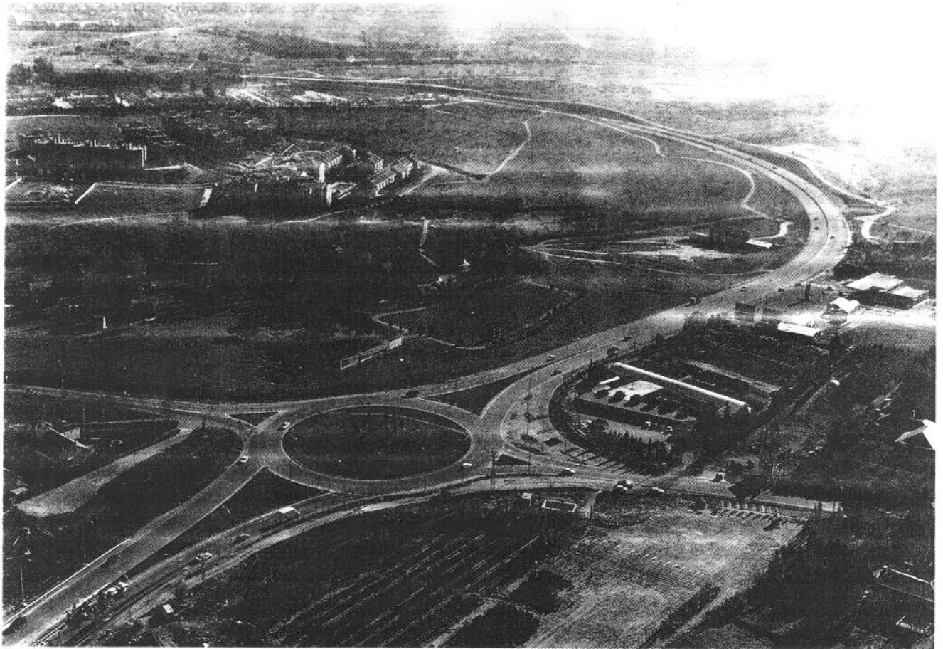
Glorieta con ramal segregado de unión en el cruce de las carreteras M-503 (IMD de 29.600 vehículos) y M-513 (IMD de 18.600 vehículos)
