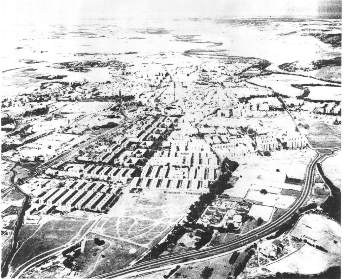
Alcalá de Henares. Variante de la M-300
