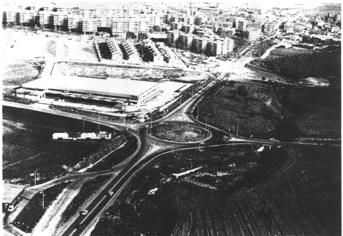
Glorieta de unión de las carreteras M-100 y M-103 al comienzo de la travesía de Algete. Su construcción ha ordenado mejor las circulaciones disminuyendo la accidentalidad de manera significativa
