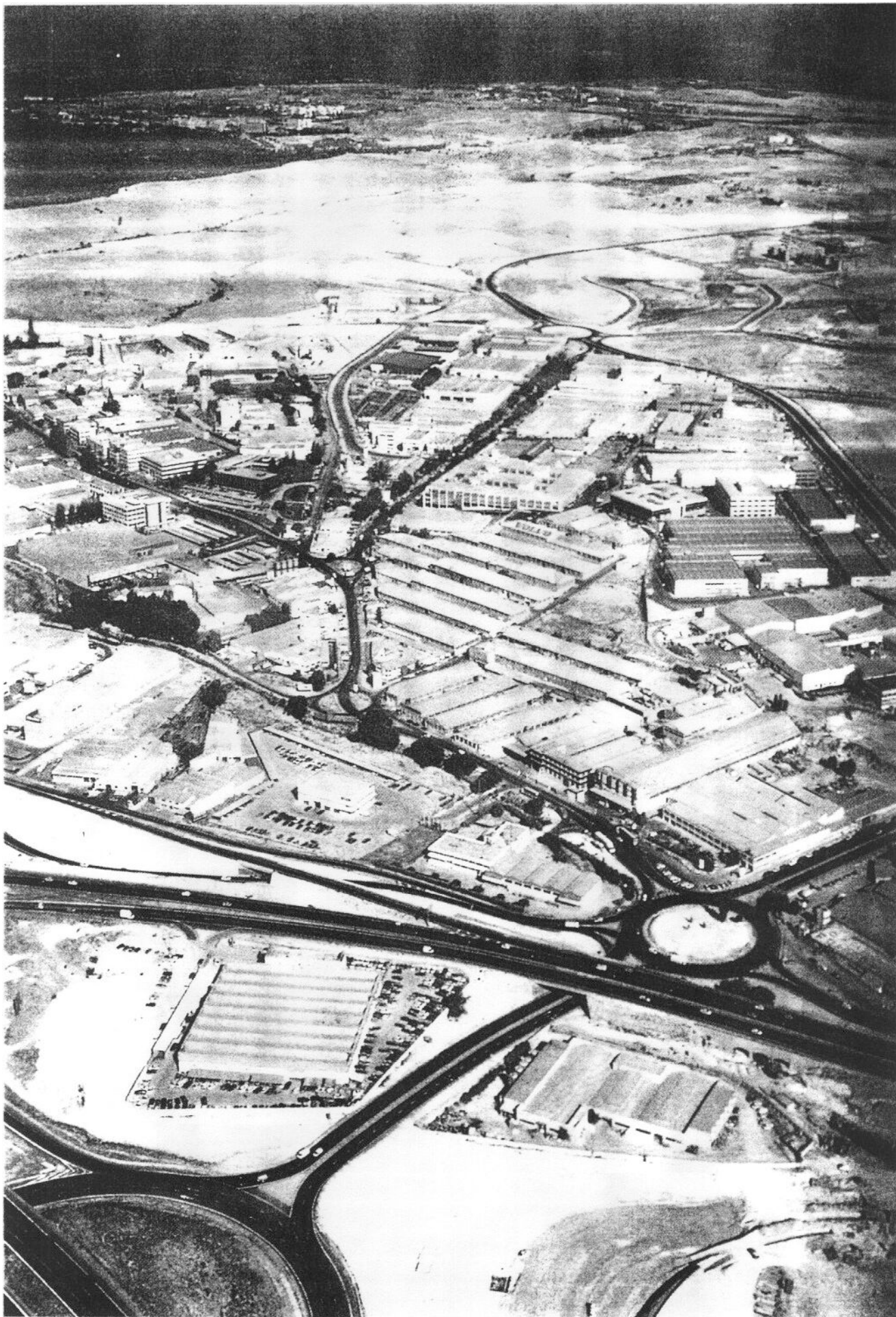
Variante de la M-616 en Alcobendas. Esta carretera conecta con la autovía de Burgos (glorieta inferior de la foto) y es una vía que se sitúa entre las antiguas áreas industriales y las zonas verdes y residenciales de reciente urbanización
