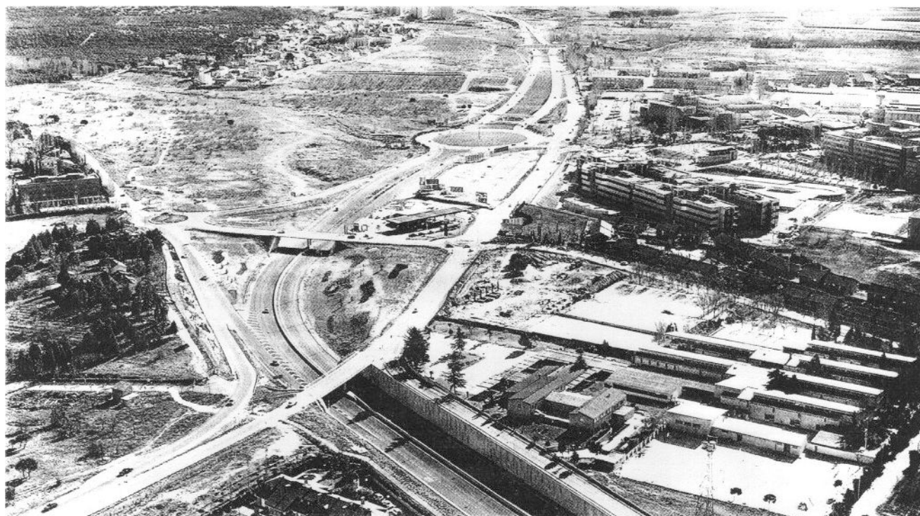
La M-502 en el oeste suburbano, las glorietas son los puntos de unión con las vías urbanas facilitando el acceso de las actividades actuales y futuras. El suelo vacante albergará el parque terciario de Arroyo Meaques
