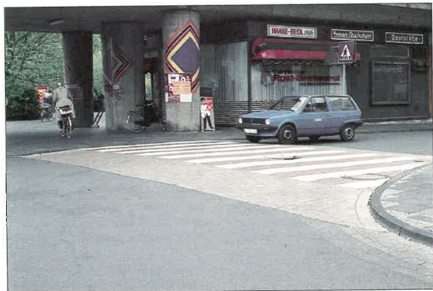
b) señalizado sobre elevación del pavimento ("lomo").
