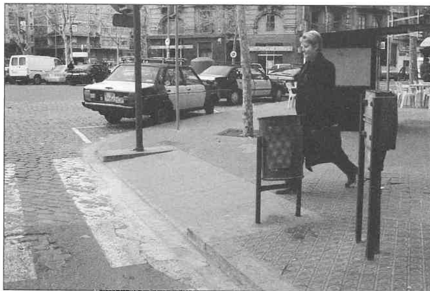
Rebaje de bordillo en Barcelona.
