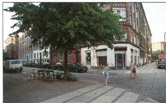
b) Pavimentación, lomo y orejas en intersección de Østerbro (Copenhague).
