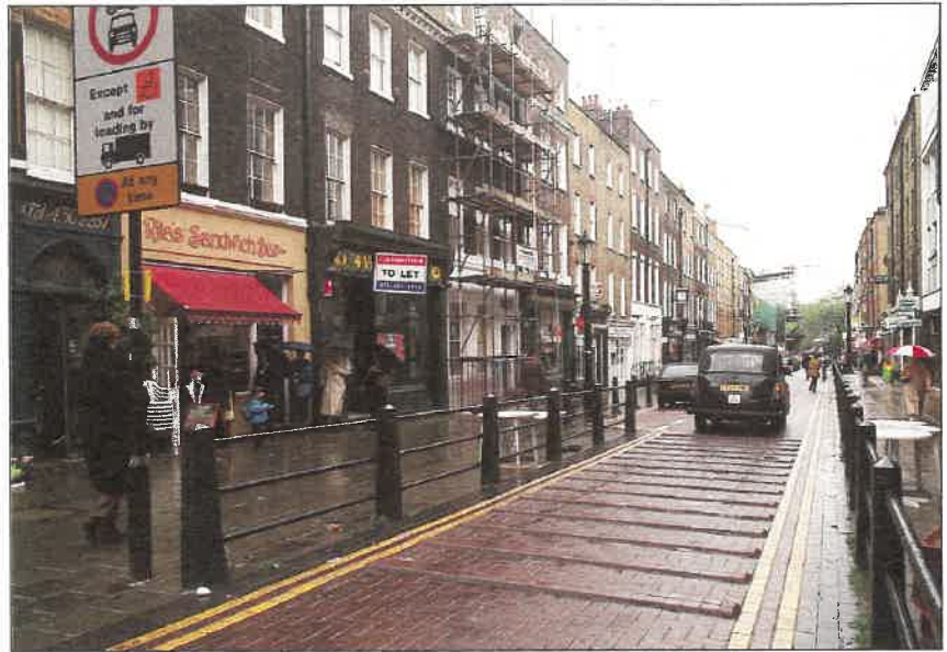
Franjas transversales de moderación de la velocidad en Londres.
