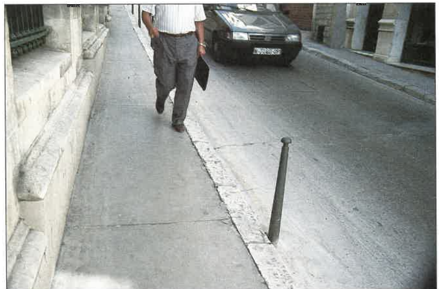
Marmolillos en la calzada para proteger la acera sin reducir la franja de circulación peatonal.
