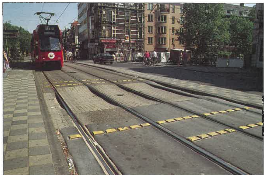
Tranvía con plataforma protegida en Amsterdam.
