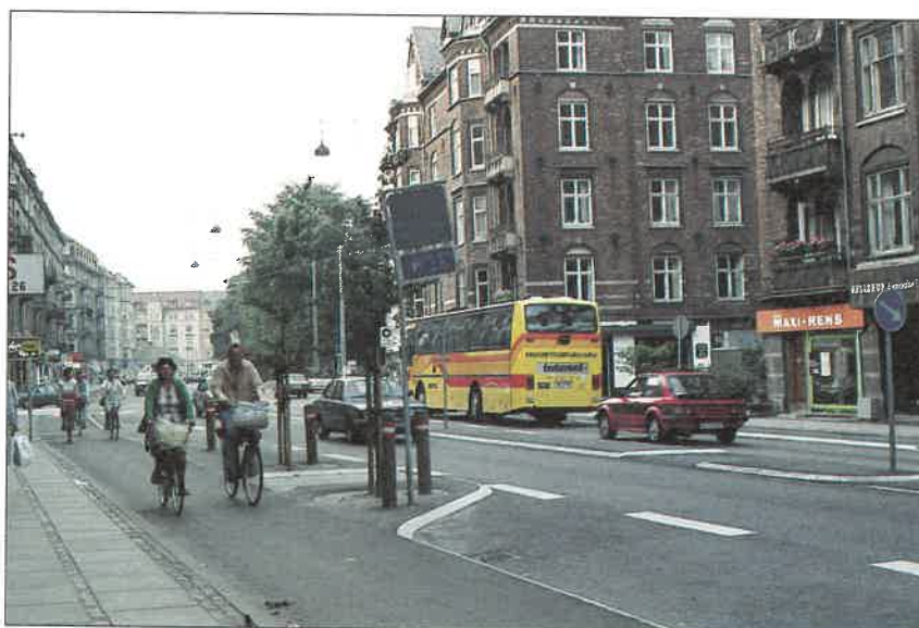
Tratamiento de travesía en Dinamarca. Reducción de calzada por creación de pista bici y franja de arbolado y aparcamiento.
