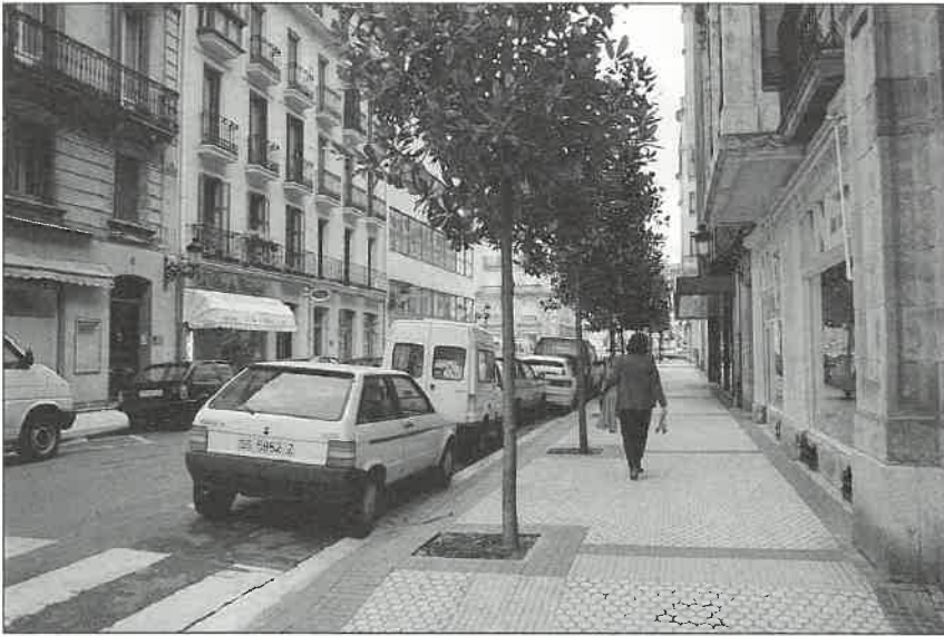
Ampliación y arbolamiento de acera en una calle de San Sebastián gracias a la reducción de la calzada y la supresión de la doble fila de aparcamiento.
