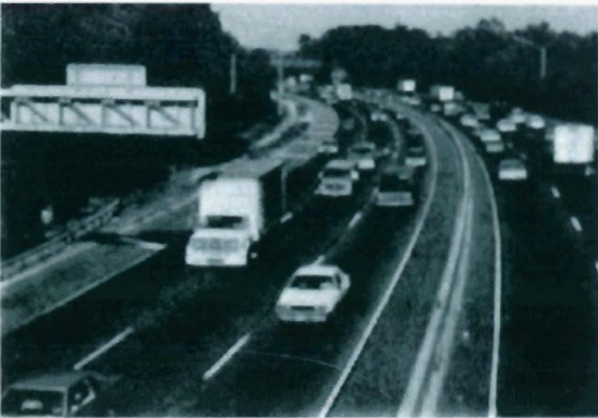
Ilustración 3-7. Nivel de servicio C.
