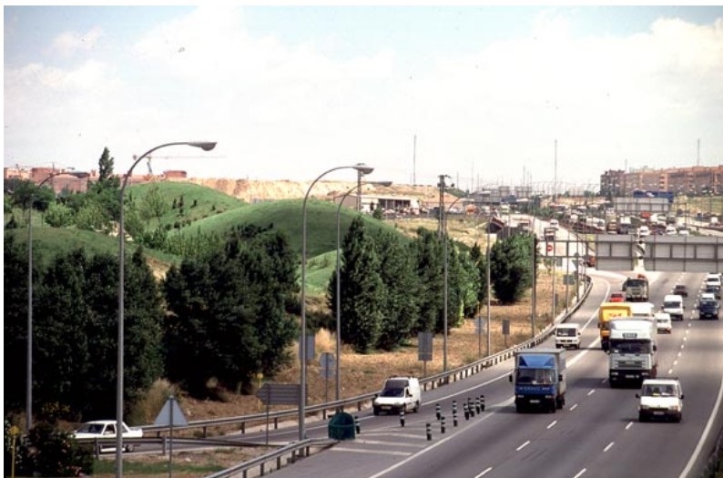
DIQUE DE TIERRA PARA AISLAMIENTO SONORO
