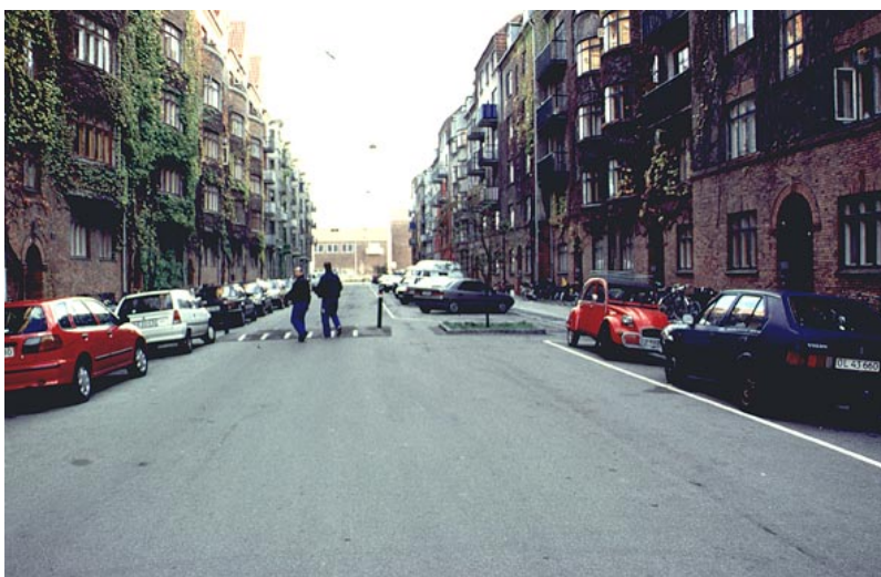
ESTRECHAMIENTO Y BADÉN CON REDUCCIÓN DE LA ANCHURA
