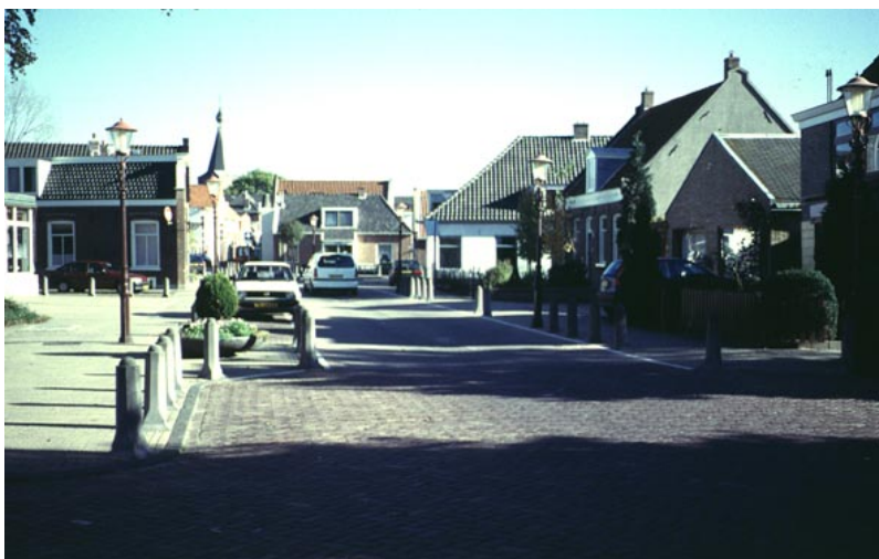
CAMBIO DE ALINEACIÓN CANALIZADO. ESTRECHAMIENTO DE CALZADA
