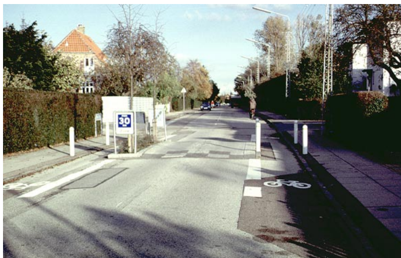
ESTRECHAMIENTO Y BADÉN CON REDUCCIÓN A UN SOLO CARRIL
