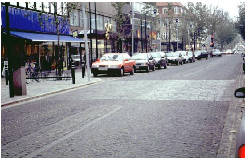
CAMBIOS DE PAVIMENTO EN ZONA CONSOLIDADA
