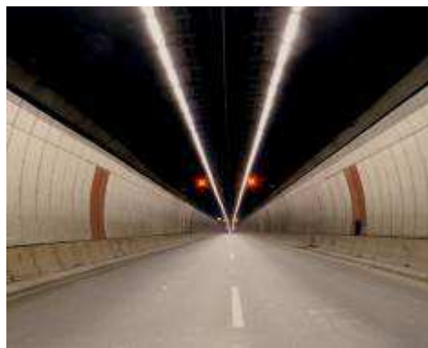
Figura 3.1. Túnel iluminado con lámparas fluorescentes.
