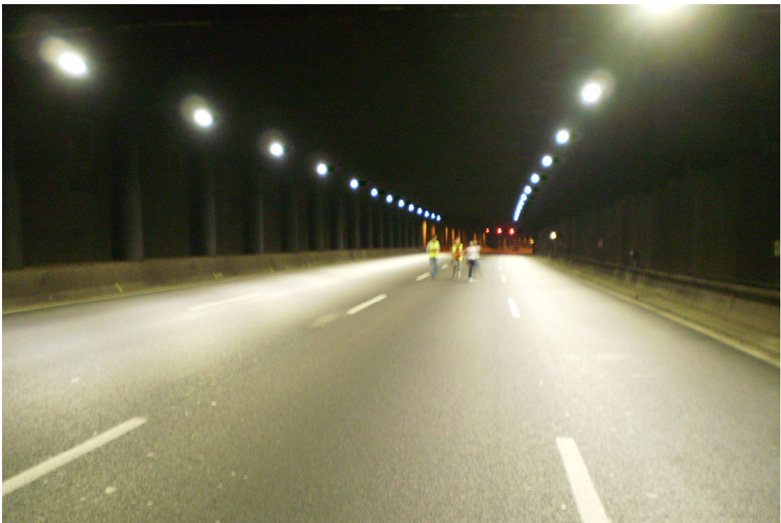
Fotografía 8. Túnel de las calzadas superpuestas M-40. Iluminación con LED. (sentido de la marcha). Luminancia media 6,95 cd/m 2 .
