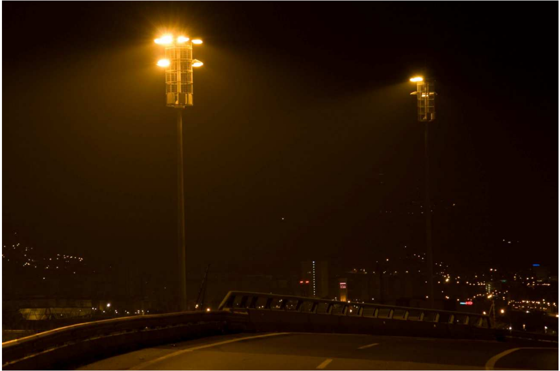
Fotografía 11. Autovía A-2. Sección tipo con dos calzadas y dos carriles cada una. Iluminación con tecnología VSAP. Torres de iluminación.
