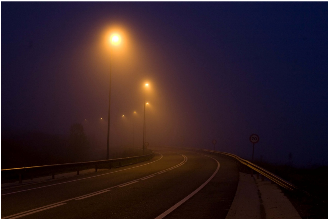
Fotografía 6. Sección tipo con una calzada y un carril por sentido. Iluminación con tecnología VSAP. Tipo de implantación: unilateral.
