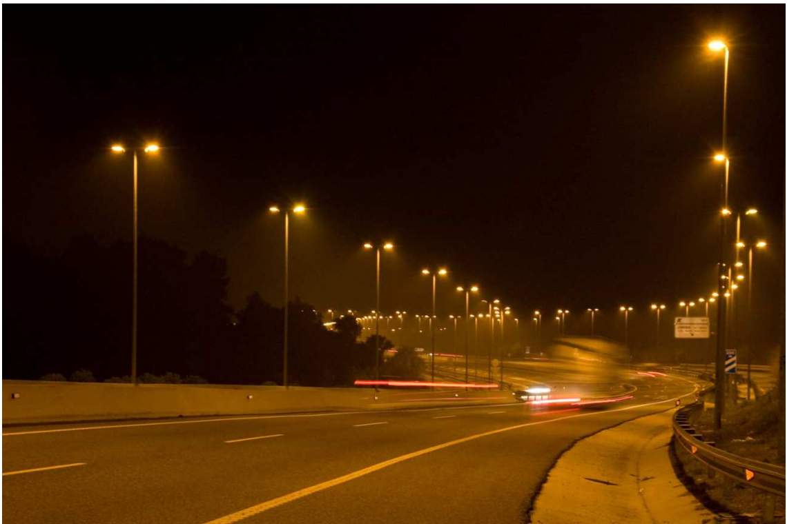
Fotografía 8. Autovía A-2. Sección tipo con dos calzadas y dos carriles cada una. Iluminación con tecnología VSAP. Tipo de implantación: axial.
