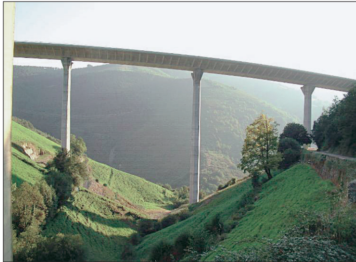
FIGURA 21. TABLERO DE LOSA/VIGAS/CAJÓN. EJEMPLO 1.
