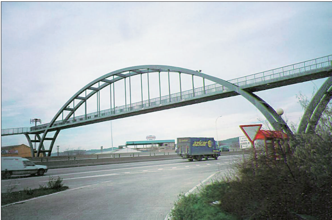
FIGURA 212. ARCO TIPO «TABLERO INTERMEDIO».
