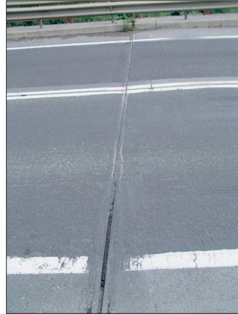
FIGURAS 131 Y 132. JUNTA DE TIPO «PERFIL DE ELASTÓMERO».
