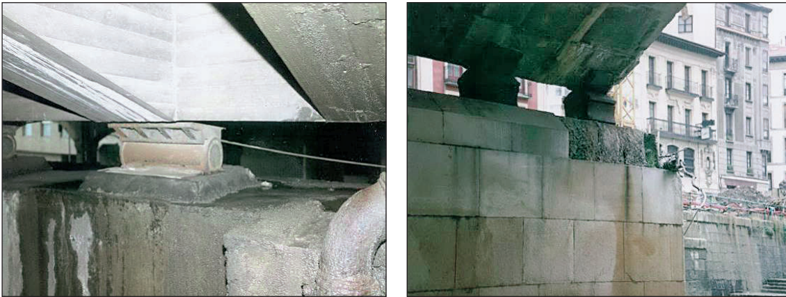
FIGURA N.º 76 Y N.º 77. RÓTULA METÁLICA.
