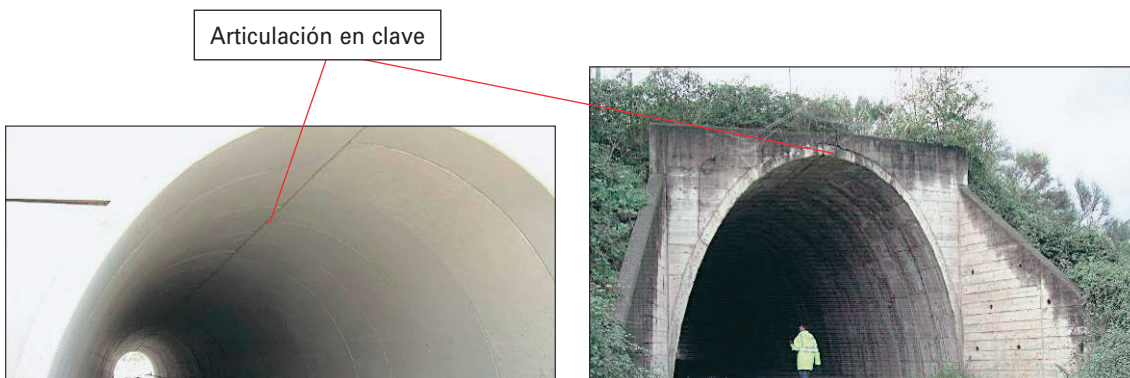
FIGURAS 204 Y 205. BÓVEDA CON ARTICULACIÓN EN CLAVE.
