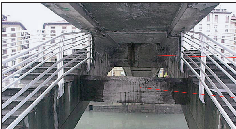
FIGURA 217. TRAVIASAS EN INTERMEDIAS Y EN CONTACTO ARCO-TABLERO.
