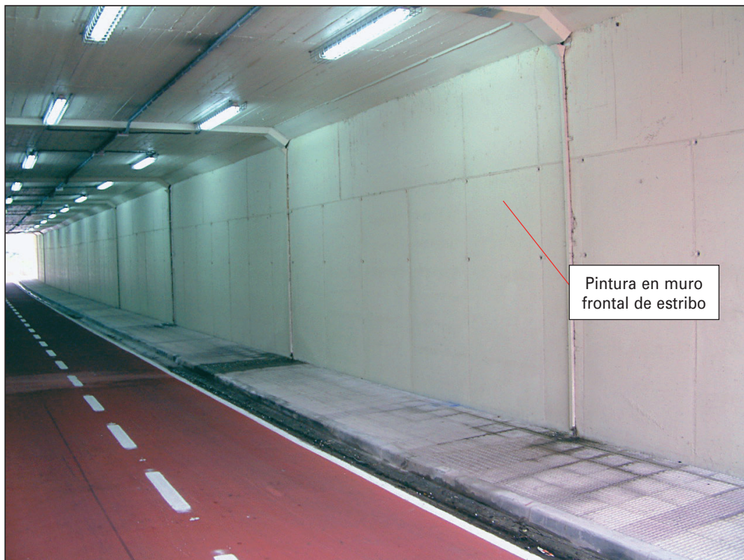
FIGURA 125. PINTURA DE PROTECCIÓN DE ESTRIBO.
