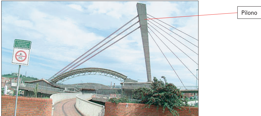
FIGURA 262. TIRANTES CON SOLUCIÓN INTERMEDIA.
