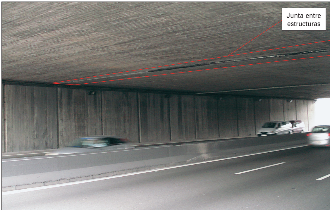
FIGURA 186. JUNTA ENTRE ESTRUCTURAS.
