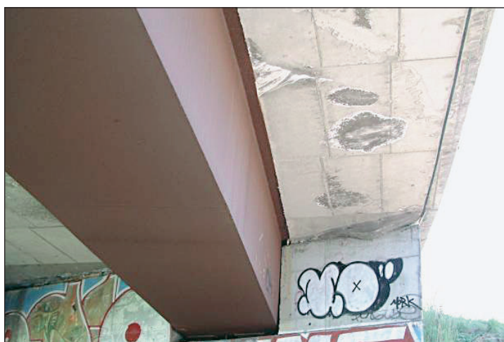
FIGURA 40. TABLERO TIPO CAJÓN.
