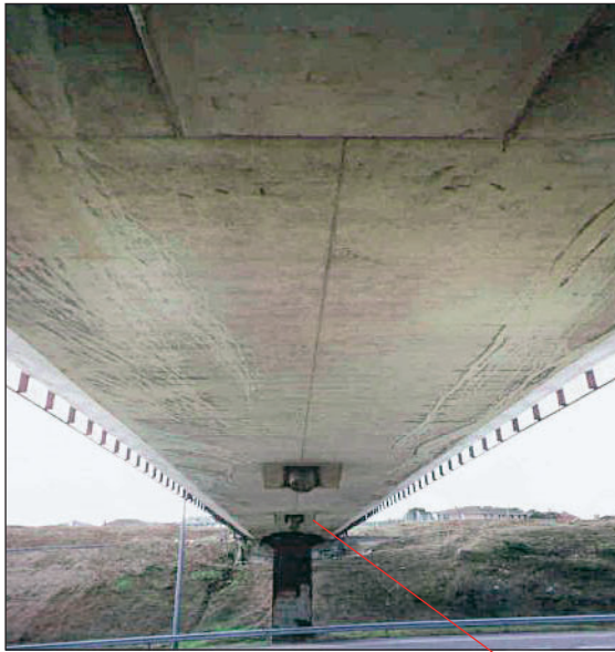
Atirantamiento al eje del tablero (ANCLAJE AL TABLERO)
