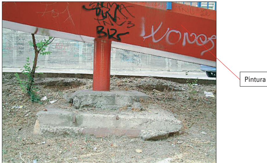
FIGURA 99. PINTURA DE PROTECCIÓN EN PILAS.
