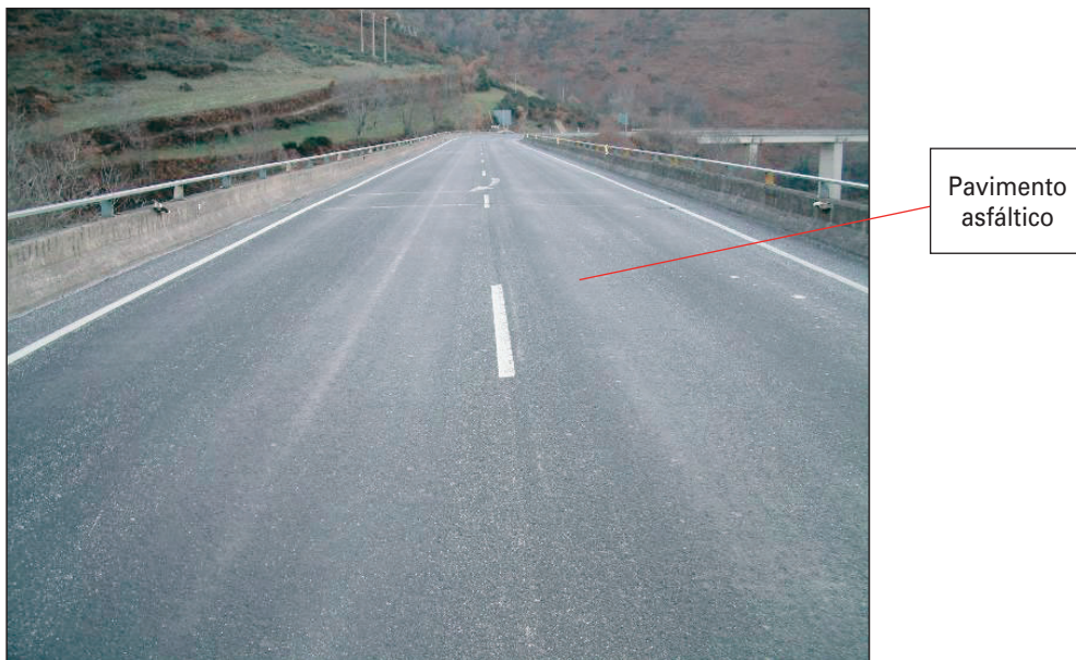
FIGURA 158. PAVIMENTO DE TIPO ASFÁLTICO.
