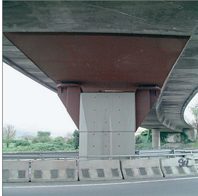
FIGURA 68. CONEXIÓN PILA – TABLERO ARTICULADA.
