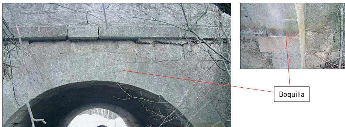
FIGURAS 196 Y 197. BOQUILLAS EN UNA BÓVEDA.
