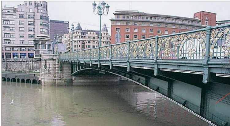
FIGURA 223. CONEXIÓN ARCO/TABLERO: TÍMPANO MACIZO.
