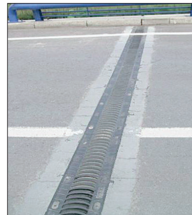
FIGURAS 133 Y 134. JUNTA DE TIPO «ELASTÓMERO ARMADO».
