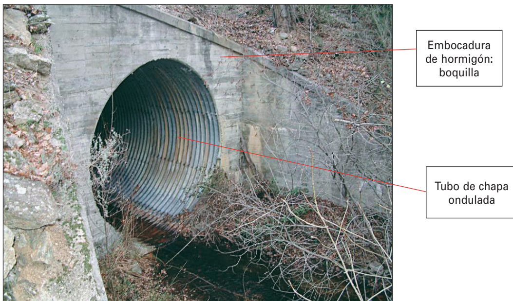
FIGURA 236. ELEMENTOS DE UN TUBO.
