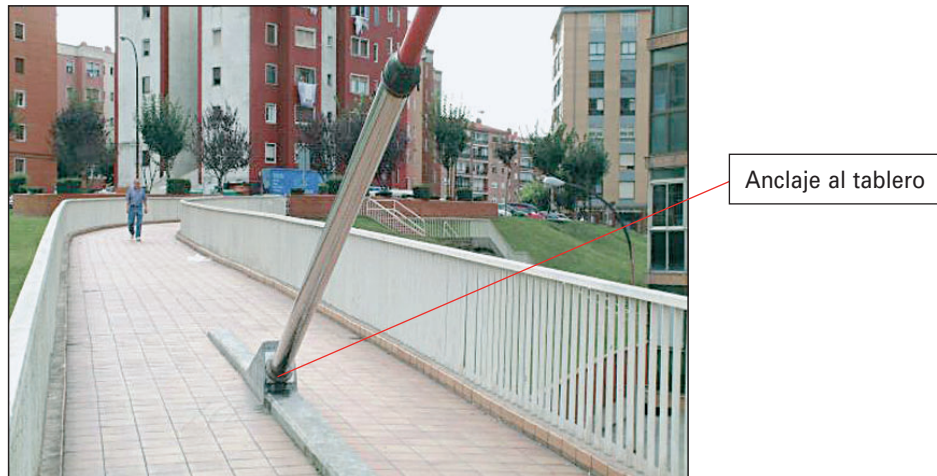
FIGURA 274. ANCLAJE TIRANTE/TABLERO.
