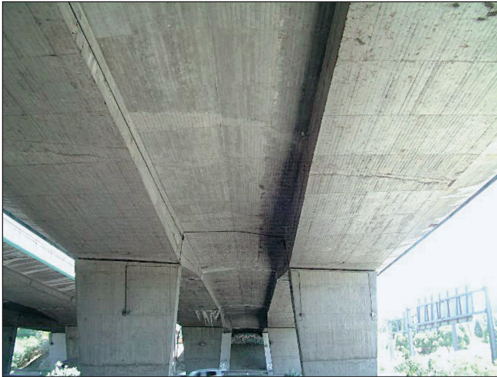
FIGURA 36. LOSA BINUCLEADA.
