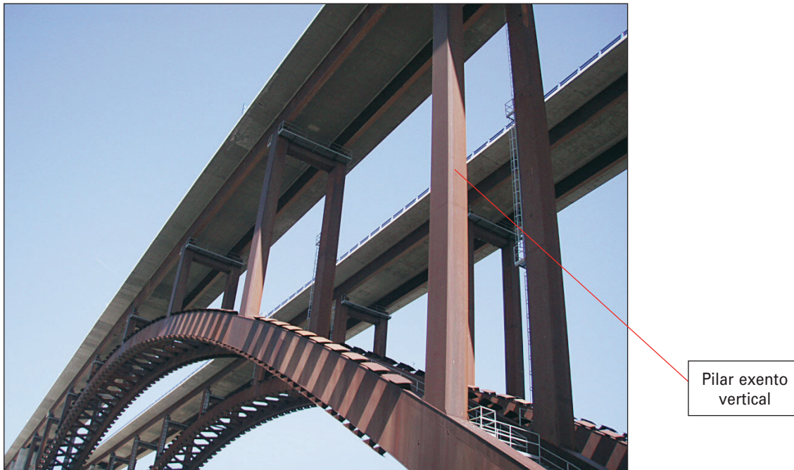
FIGURA 227. CONEXIÓN ARCO/TABLERO: PILARES VERTICALES.
