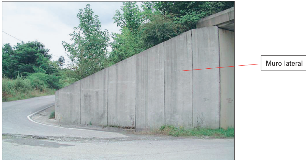
FIGURA 240. MUROS LATERALES DE UN MARCO.
