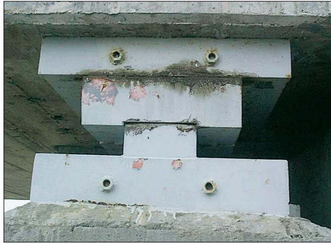
FIGURA 84. APOYO DESLIZANTE.
