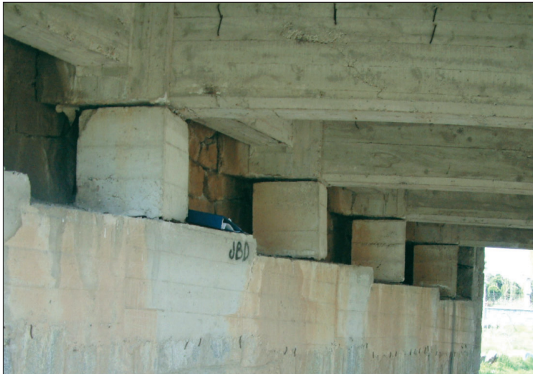
FIGURA 78. DADO DE HORMIGÓN.
