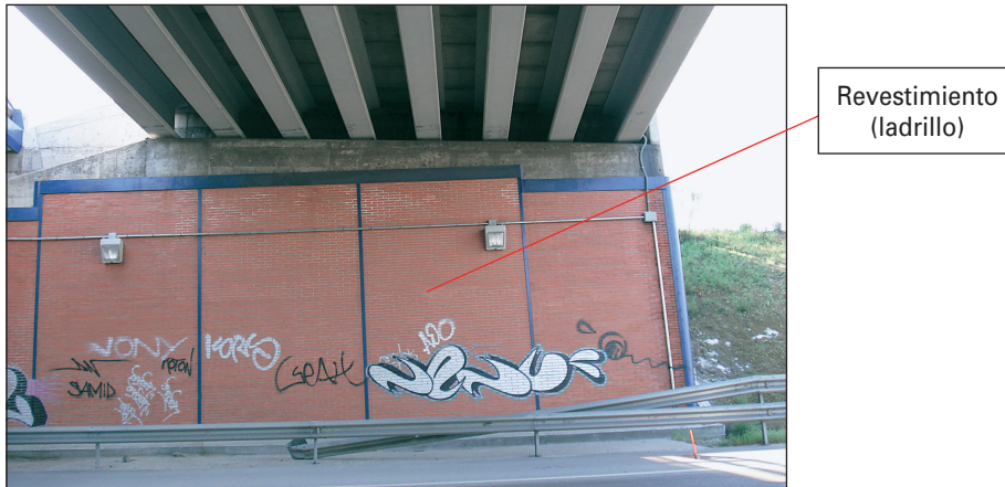
FIGURA 126. REVESTIMIENTO DE LADRILLO DE UN ESTRIBO.
