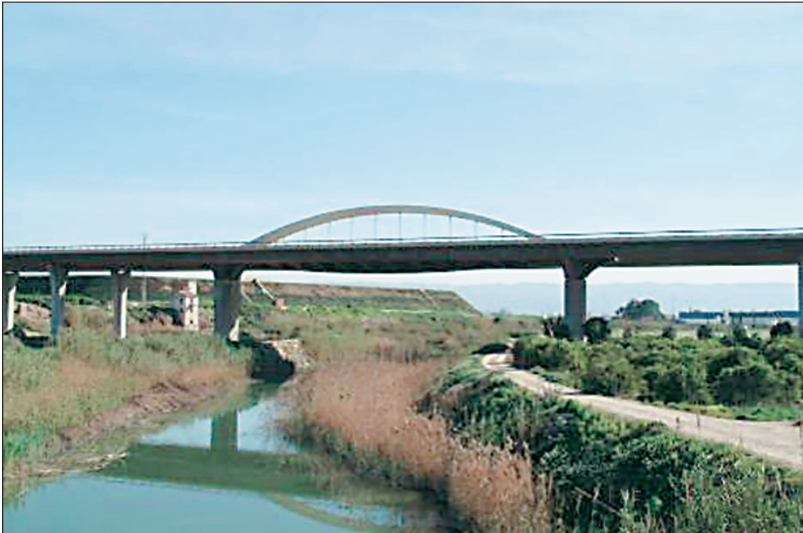
FIGURA 211. ARCO TIPO «TABLERO INFERIOR».
