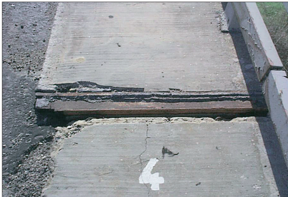
FIGURA 140. JUNTA DE TIPO «ABIERTA».
