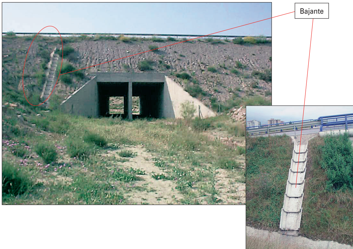
FIGURAS 155 Y 156. PROTECCIÓN DEL TERRAPLÉN MEDIANTE BAJANTES.
