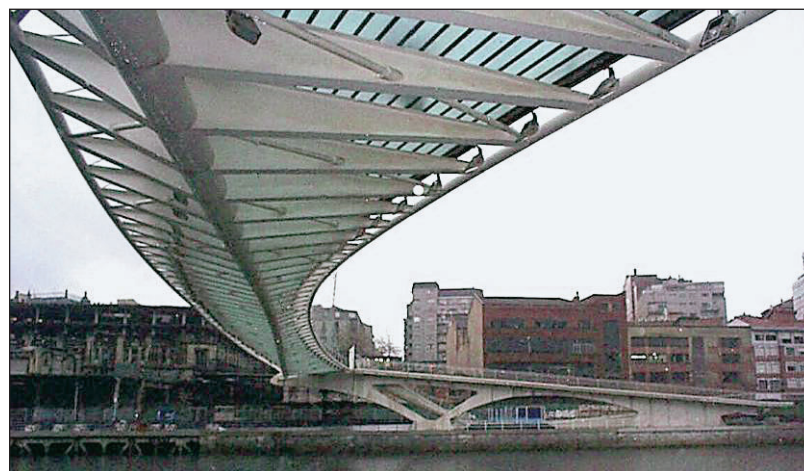
FIGURA 64. PILAS EN V.
