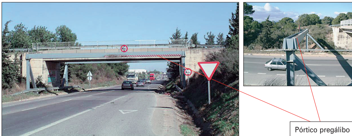
FIGURAS N.º 142 Y N.º 143. PÓRTICO PREGÁLIBO COMO ELEMENTO DE PROTECCIÓN.
