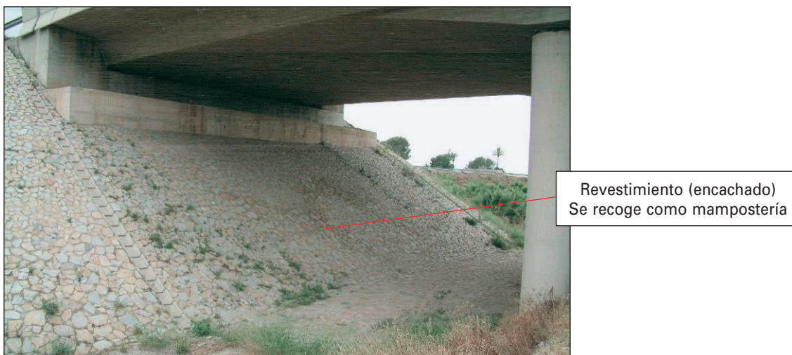
FIGURA 153. PROTECCIÓN DEL TERRAPLÉN MEDIANTE REVESTIMIENTO.
