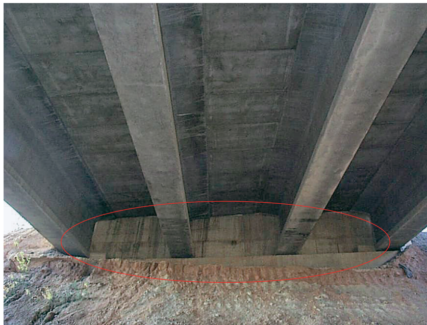
FIGURA 118. MURETE DE GUARDA.
