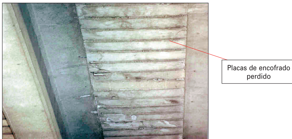
FIGURA 51. PLACAS DE ENCOFRADO PERDIDO.
