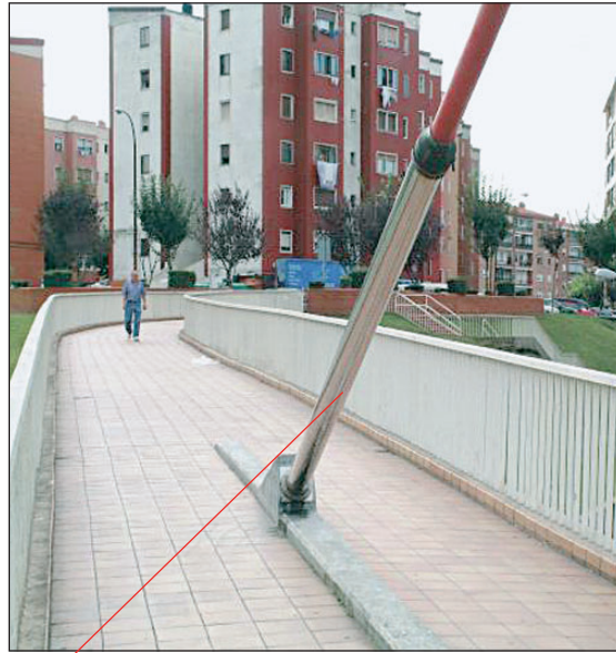
Atirantamiento al eje del tablero (ANCLAJE AL TABLERO)
