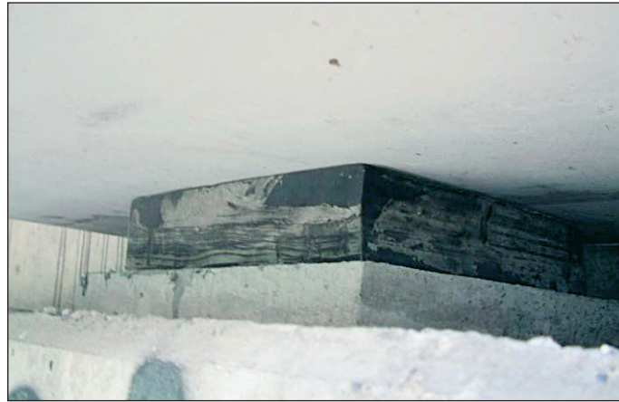
FIGURA 88. ELASTÓMERO ZUNCHADO.
