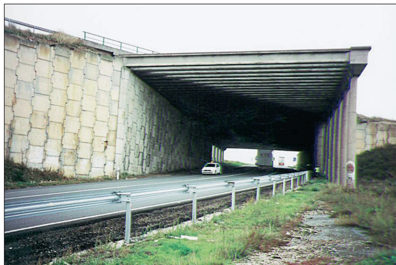
FIGURA 23. TABLERO DE LOSA/VIGAS/CAJÓN. EJEMPLO 3.
