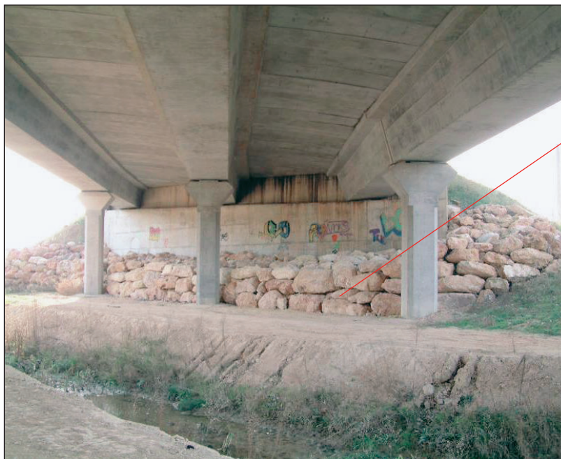
FIGURA 149. PROTECCIÓN FRENTE A LA SOCAVACIÓN.
