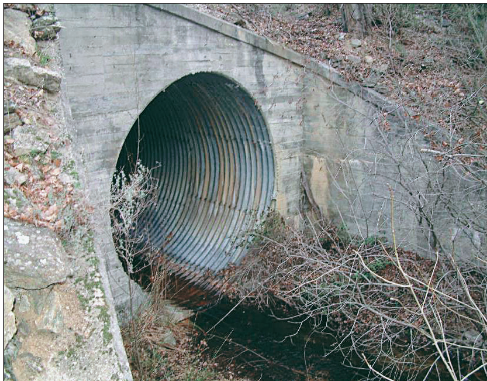
FIGURA 27. OBRA DE PASO TIPO TUBO.
