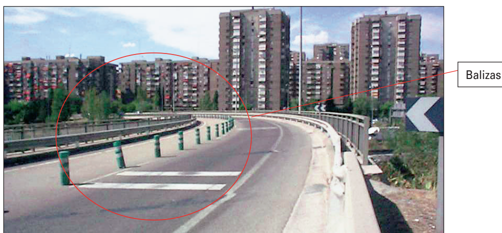
FIGURA 145. SEÑALIZACIÓN MEDIANTE BALIZAS.
