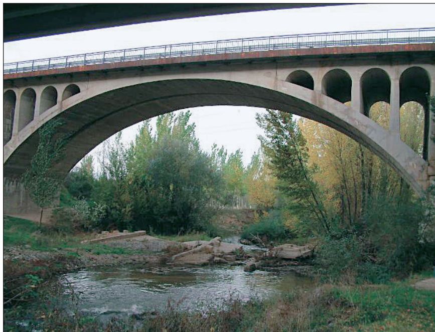
FIGURA 230. TIPOLOGÍA DEL TABLERO: BÓVEDA.
