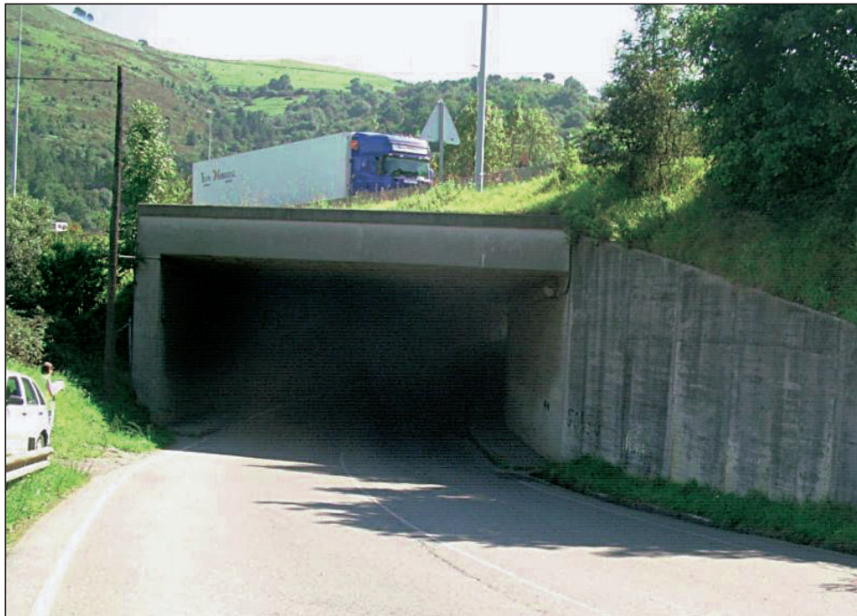
FIGURA 26. TABLERO TIPO MARCO.
