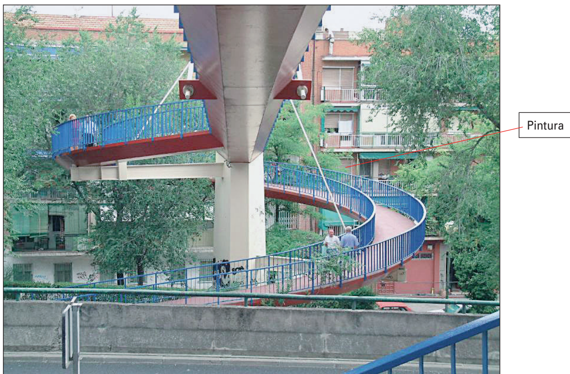
FIGURA 56. PINTURA DE PROTECCIÓN EN ELEMENTOS.
