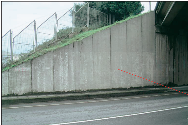
FIGURA 119. MURO LATERAL DE CONTRAFUERTE.
