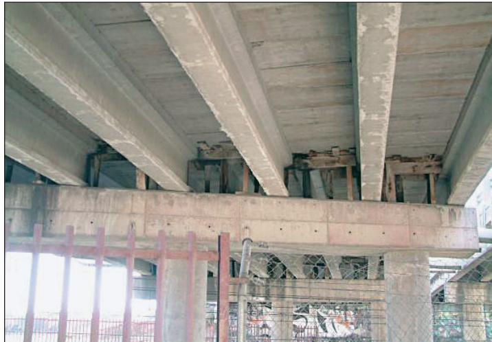
FIGURA 38. TABLERO DE VIGAS.
