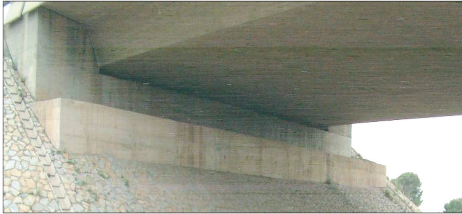
FIGURA 117. CONEXIÓN ESTRIBO - TABLERO EN UN ESTRIBO.
