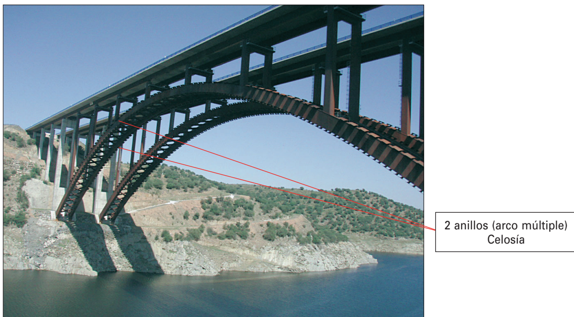
FIGURA 214. ANILLO MÚLTIPLE DE SECCIÓN CELOSÍA.
