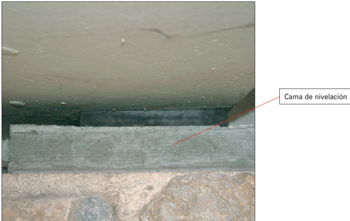
FIGURA 45. CAMA DE NIVELACIÓN DE APARATO DE APOYO.
