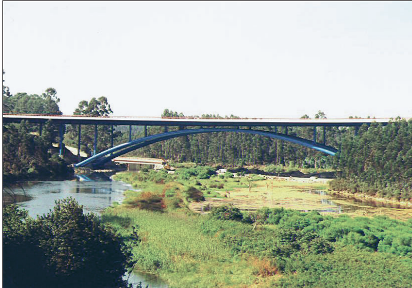
FIGURA 24. TABLERO TIPO ARCO.
