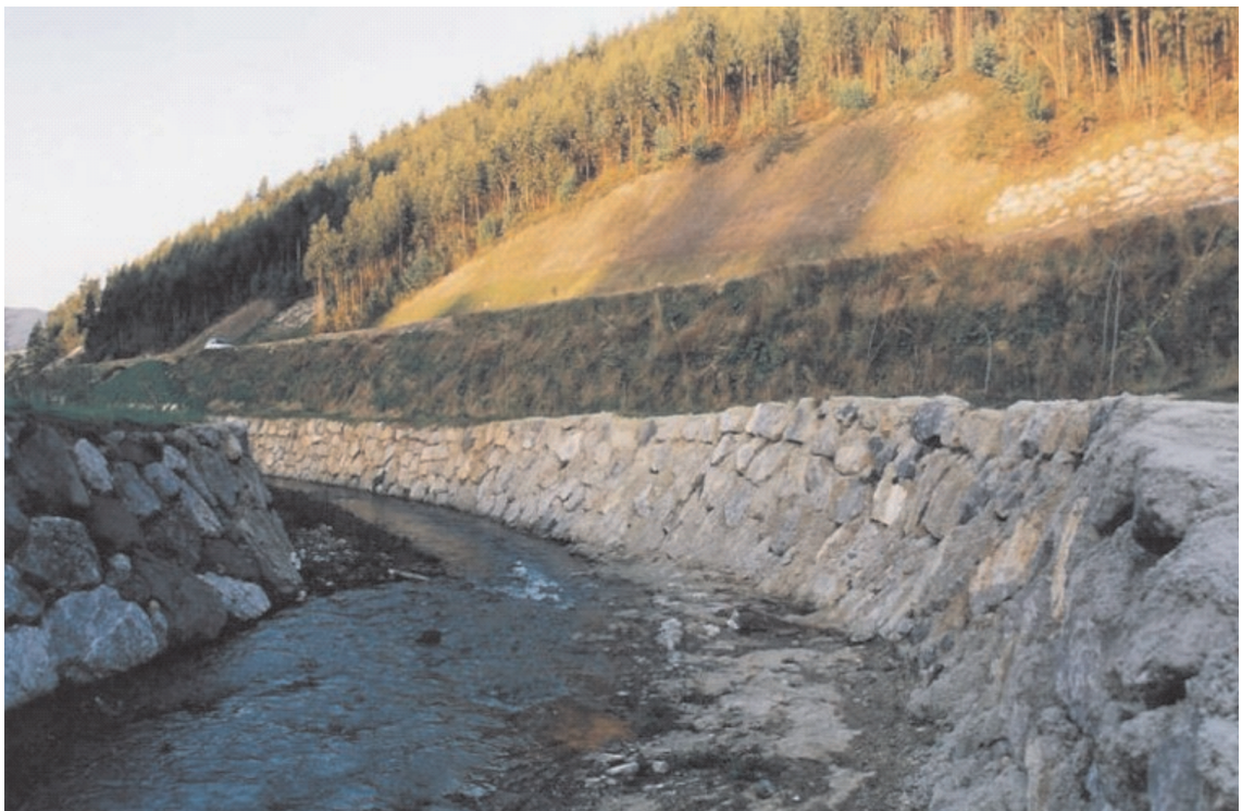
FIGURA 1.2. MURO DE ESCOLLERA EN UN ENCAUZAMIENTO FLUVIAL.
