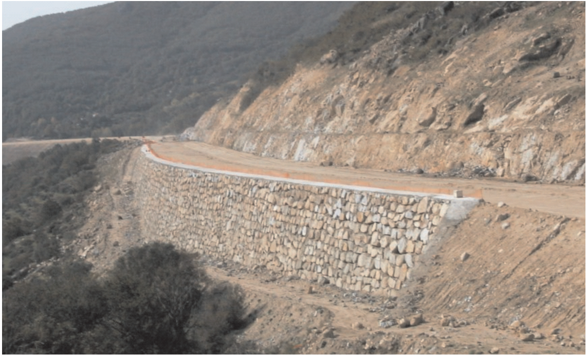
FIGURA 1.4. MURO DE SOSTENIMIENTO DE ESCOLLERA COLOCADA.
