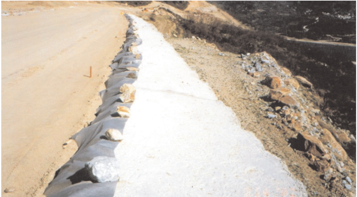
FIGURA 5.10. CORONACIÓN HORMIGONADA PARA LA MATERIALIZACIÓN DE REFERENCIAS TOPOGRÁFICAS.
