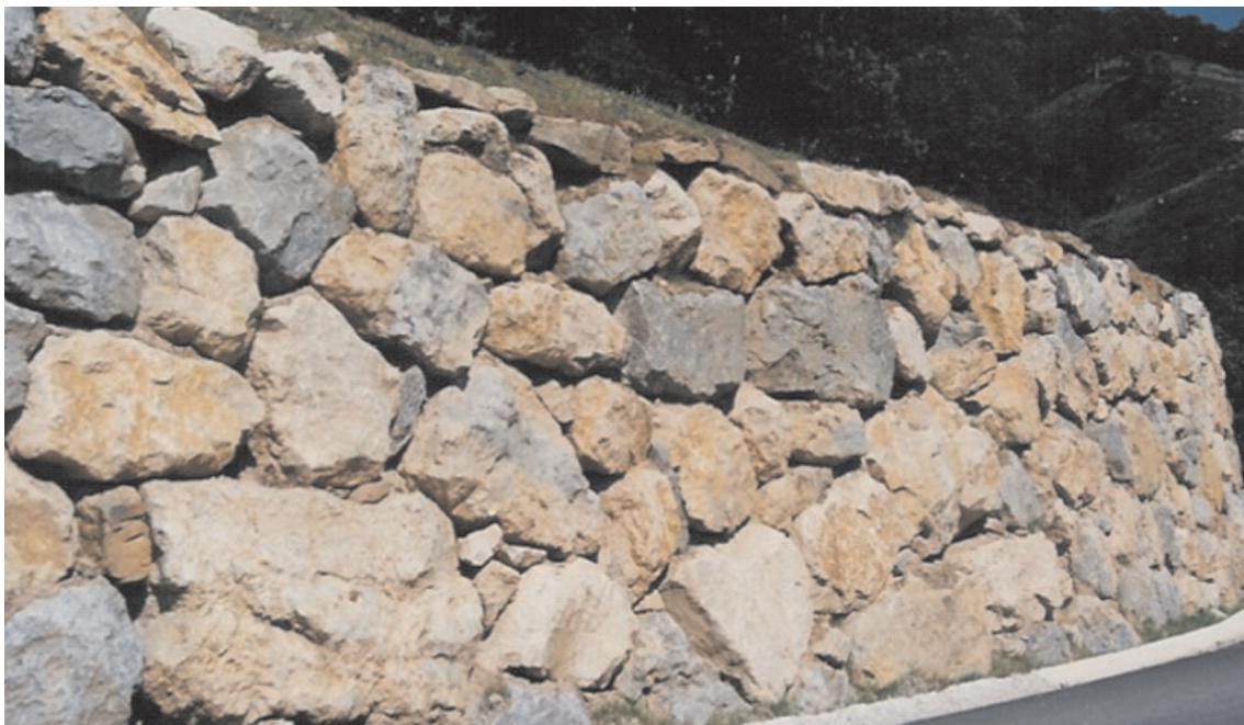
FIGURA 1.3. MURO DE CONTENCIÓN DE ESCOLLERA COLOCADA.
