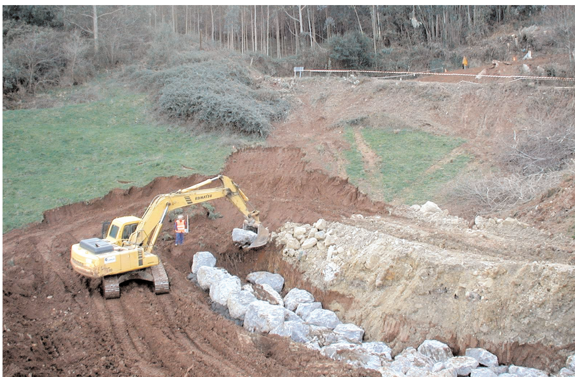
FIGURA 5.2. COLOCACIÓN DE BLOQUES EN EL CIMIENTTO.
