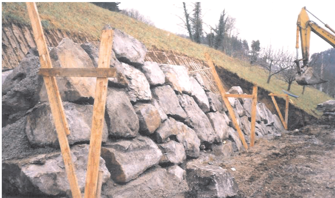
FIGURA 5.9. REFERENCIAS GEOMÉTRICAS PARA AYUDA DEL MAQUINISTA.
