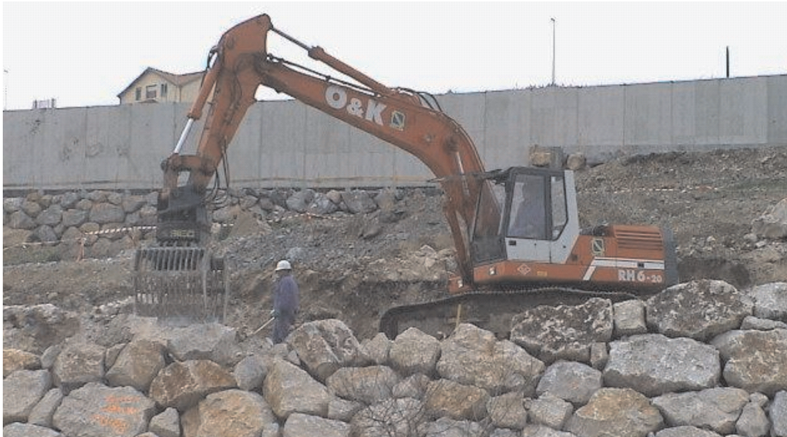
FIGURA 5.8. EJECUCIÓN MEDIANTE EXCAVADORA CON PINZA.
