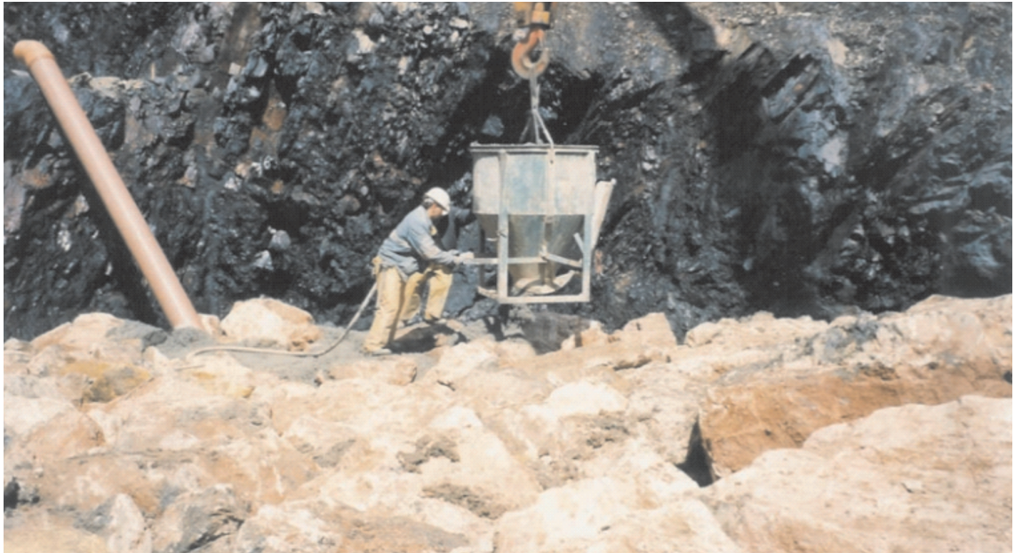
FIGURA 5.4. HORMIGONADO DE LA CIMENTACIÓN.
