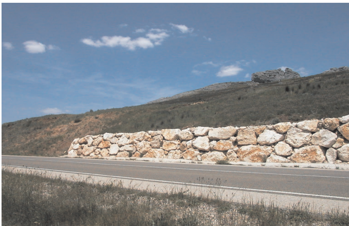
FIGURA 2.4. MURO DE CONTENCIÓN PARA CORRECCIÓN DE UN MOVIMIENTO DE LADERA.
