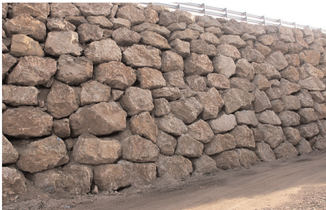
FIGURA 2.5. EJEMPLO DE MURO DE SOSTENIMIENTO.
