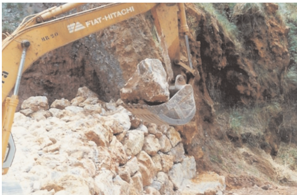
FIGURA A-1.1. EXCAVADORA CON CAZO.
