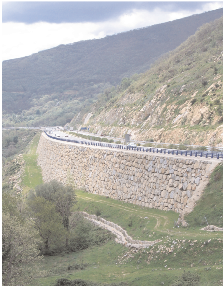
FIGURA 5.11. MURO DE ESCOLLERA DE SOSTENIMIENTO CON CAMINO DE SERVICIO AL PIE, UTILIZABLE PARA LA COLOCACIÓN DE REFERENCIAS TOPOGRÁFICAS.
