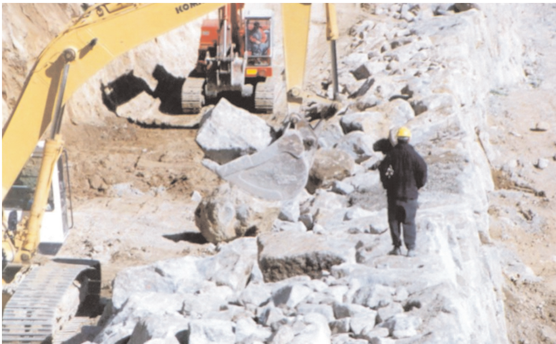
FIGURA 5.7. EJECUCIÓN MEDIANTE EXCAVADORA CON CAZO.
