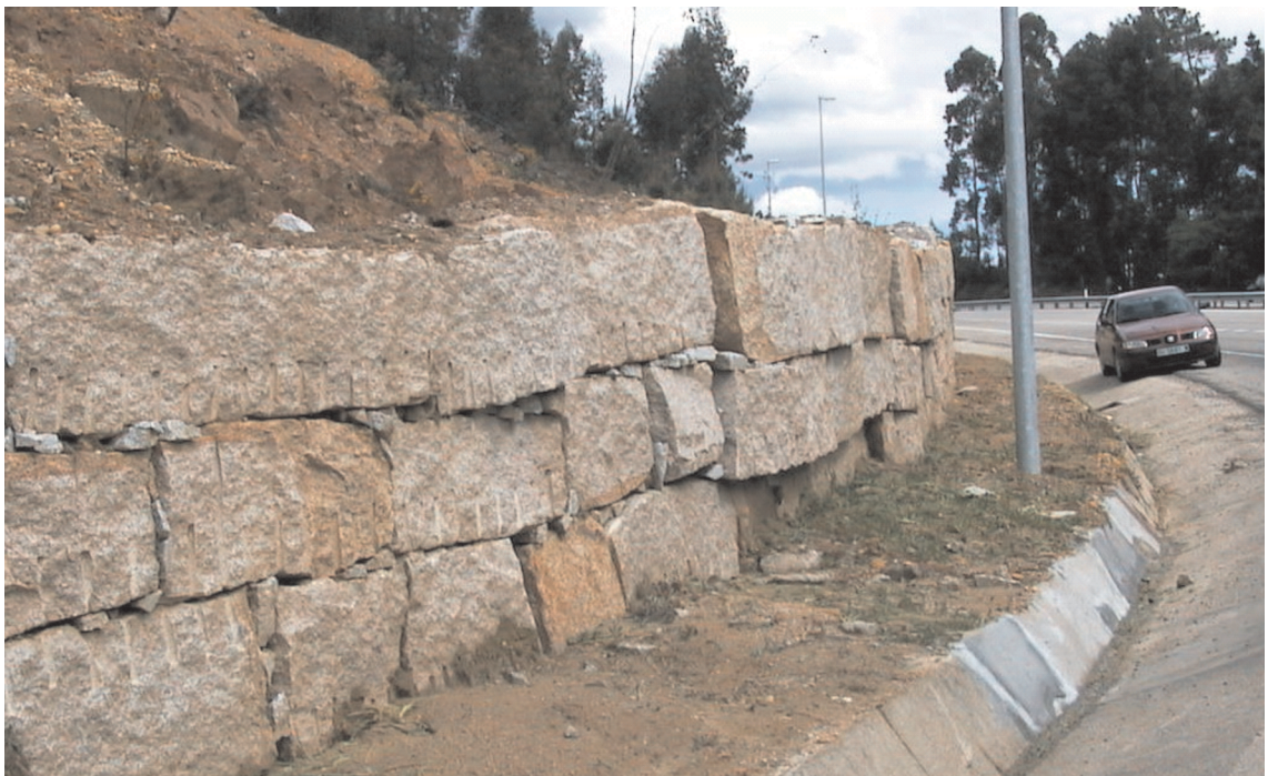
FIGURA 1.5. MURO DE CONTENCIÓN DE BLOQUES PARALELEPIPÉDICOS
