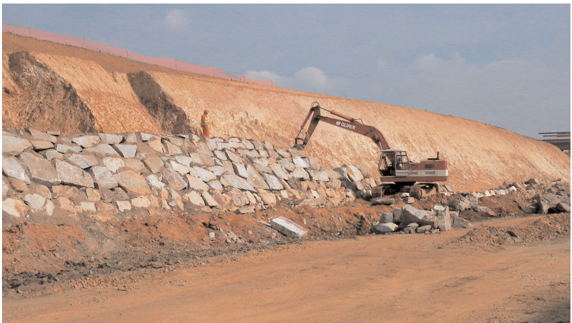
FIGURA 5.5. FORMACIÓN DEL CUERPO DEL MURO.
