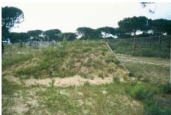
Figura 15.3 – Sistema de escape consistente en tierras que forman una rampa, visto desde el interior de la vía. Foto: H. Bekker.
