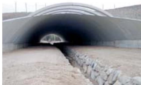
Figura 6.3 – Bóveda que permite una gran sección sin tabiques, antes de iniciar la restauración. Foto: C. Rosell.
