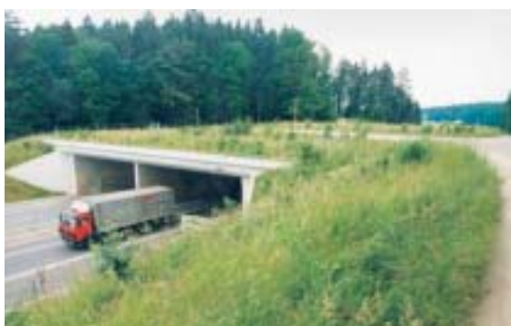
Figura 3.2 – Márgenes con vegetación que se prolonga por la superficie del paso. Foto: V. Hlavac.
