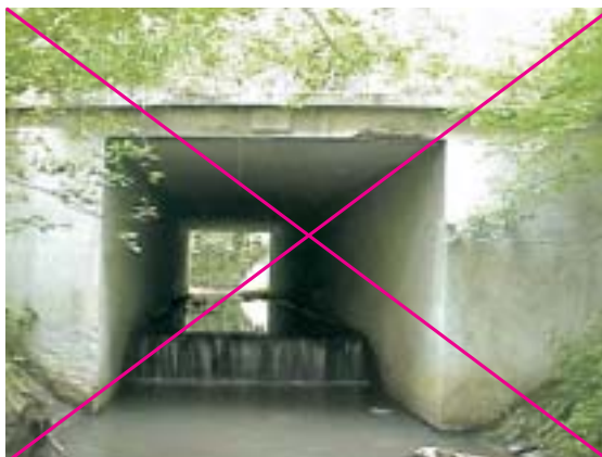
Figura 10.4 – Escalón con el interior del drenaje que supone un obstáculo para el movimiento de fauna acuática. Foto: J. Dufek.
