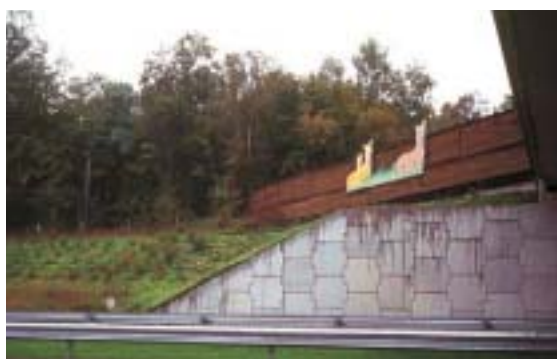
Figura 2.5 – Siluetas colocadas en las pantallas protectoras que informan a los usuarios de la vía de la existencia de un paso de fauna. Foto: C. Rosell.
