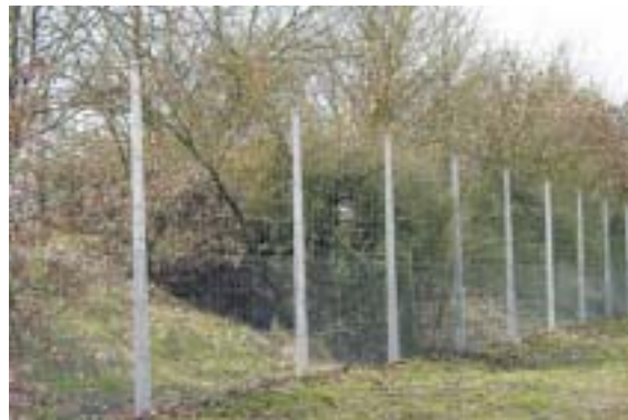
Figura 14.3 – Malla que presenta un tramo de mayor densidad en la parte inferior. Foto: F. Navàs.
