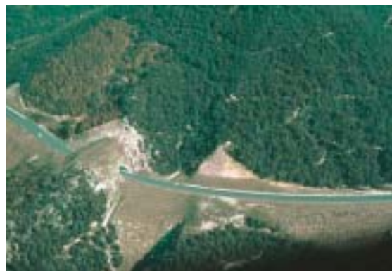
Figura 1.4 – Un falso túnel constituye una oportunidad para establecer un ecoducto, pero debe restaurarse adecuadamente su superficie. Foto: M. Pey.
