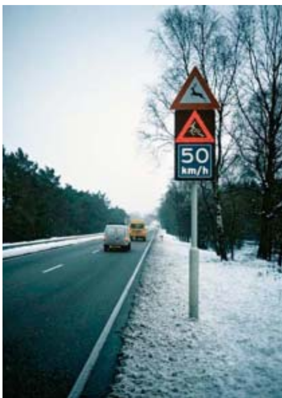
Figura 17.2 – Refuerzo de señalización de advertencia y limitación de velocidad mediante destellos luminosos. Foto: H. Bekker.
