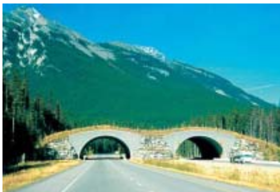
Figura 1.3 – Bóvedas que permitieron la construcción del ecoducto con la vía en funcionamiento. Foto: H. Bekker.
