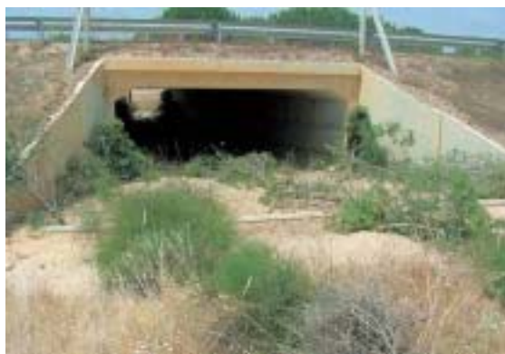
Figura 12.5 – Accesos a un paso inferior con revegetaciones e hileras de ramas. Foto: P. Robles.
