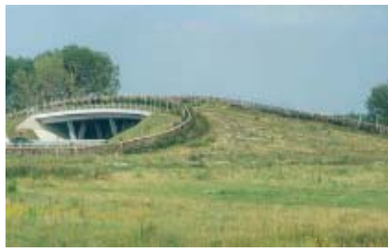
Figura 2.3 – Paso situado en un terreno llano, con rampas de ligera pendiente. Foto: P. Farkas.
