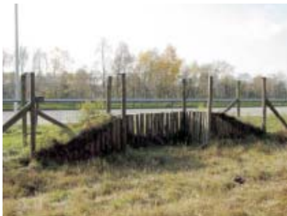
Figura 15.1 – Rampas diseñadas para permitir la salida de corzos desde el interior de un tramo vallado. Foto: C. Rosell.
