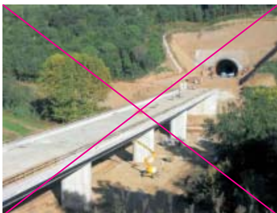
Figura 5.7 – Destrucción completa de los hábitats del cauce durante la fase de construcción. Foto: C. Rosell.
