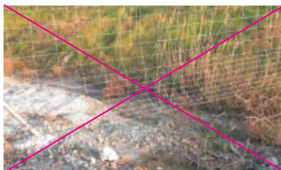
Figura 13.10 – Malla sin enterrar que ha sido levantada por los animales. Foto: F. Navàs.
