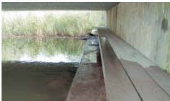
Figura 9.5 – Plataformas de hormigón y madera superpuestas en dos niveles. Foto: F. Navàs.
