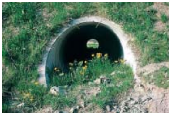
Figura 8.5 – Integración del acceso en los taludes del terraplén. Foto: V. Keller.
