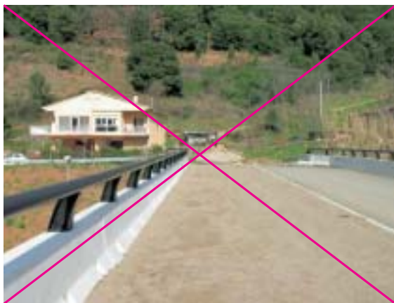
Figura 3.6 – La franja lateral destinada a la fauna debería estar cubierta de tierra, en este caso se han utilizado gravas. Además, la ubicación es poco adecuada debido a la proximidad de edificaciones. Foto: F. Navàs.
