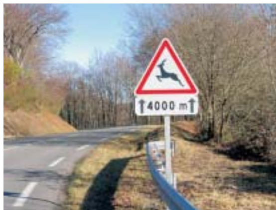
Figura 16.3 – El desbroce de los márgenes se combina con un refuerzo de señalización de advertencia de peligro por presencia de fauna silvestre. Foto: R. Campeny.
