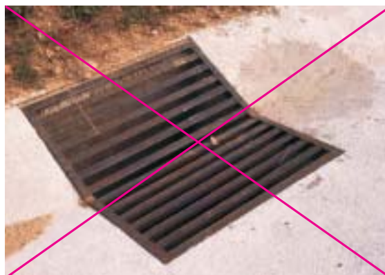
Figura 20.5 – Las rejillas protectoras deben ser muy densas para evitar la caída de pequeños animales. Además siempre es preferible que las paredes de las arquetas o pozos se adapten para facilitar la salida de animales. Foto: C. Rosell.
