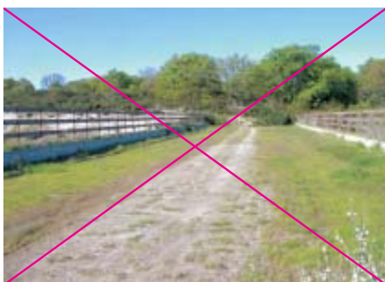
Figura 2.8 – Circulación motorizada por un paso superior específico para la fauna. Foto: C. Rosell.
