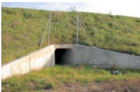
Figura 8.2 – La colocación del cerramiento facilita la localización de accesos. Foto: F. Navàs.
