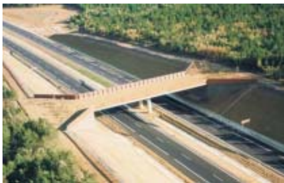
Figura 2.2 – Paso situado en un tramo en trinchera. Foto: J.A. Ruiz, Junta de Castilla y la Mancha.
