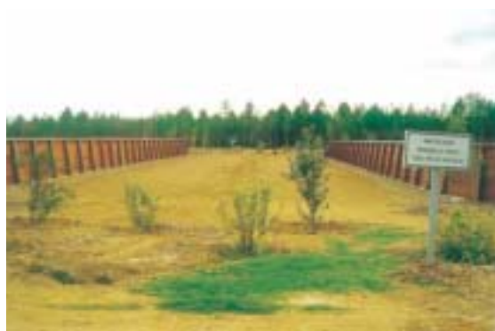
Figura 2.7 – Revegetación en los accesos de un paso para dificultar la circulación de vehículos. Foto: C. Rosell.
