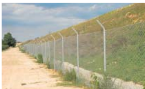
Figura 13.2 – Instalación del cerramiento en la base de un terraplén. Foto: F. Navàs.
