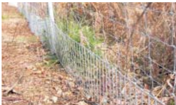
Figura 13.5 – Refuerzo para jabalí en un tramo del vallado especialmente conflictivo. Foto: C. Rosell.
