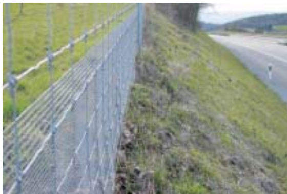
Figura 14.2 – Instalación de un refuerzo en la parte exterior de la malla convencional. Foto: C. Rosell.
