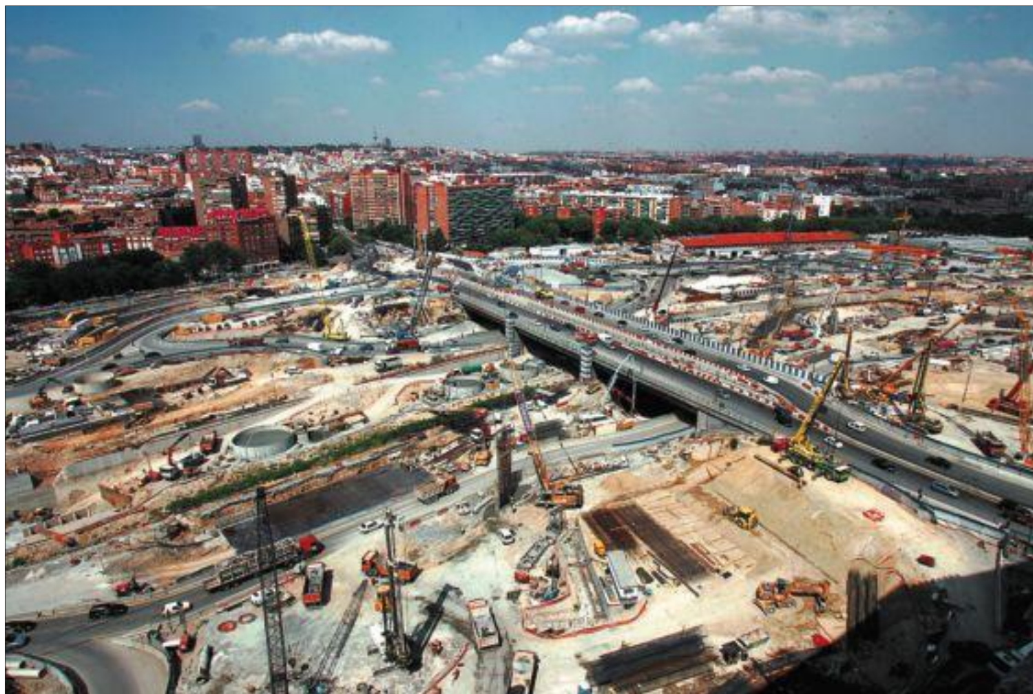
La M-30, en el puente de Praga, en plenos trabajos de reforma en junio de 2006. / LUIS MAGÁN
