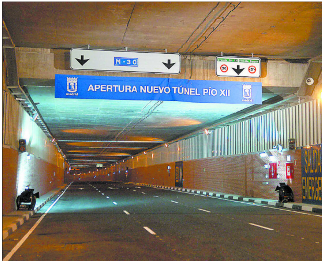
Vista del nuevo túnel de Pío XII, inaugurado ayer, que discurre bajo el paseo de la Castellana. / EFE
