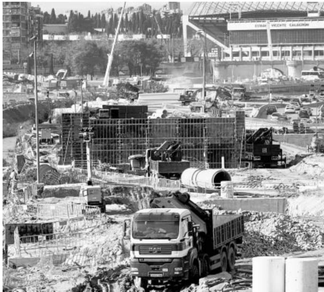
Los estudios ambientales determinarán si hace falta incluir medidas compensatorias tras las obras
