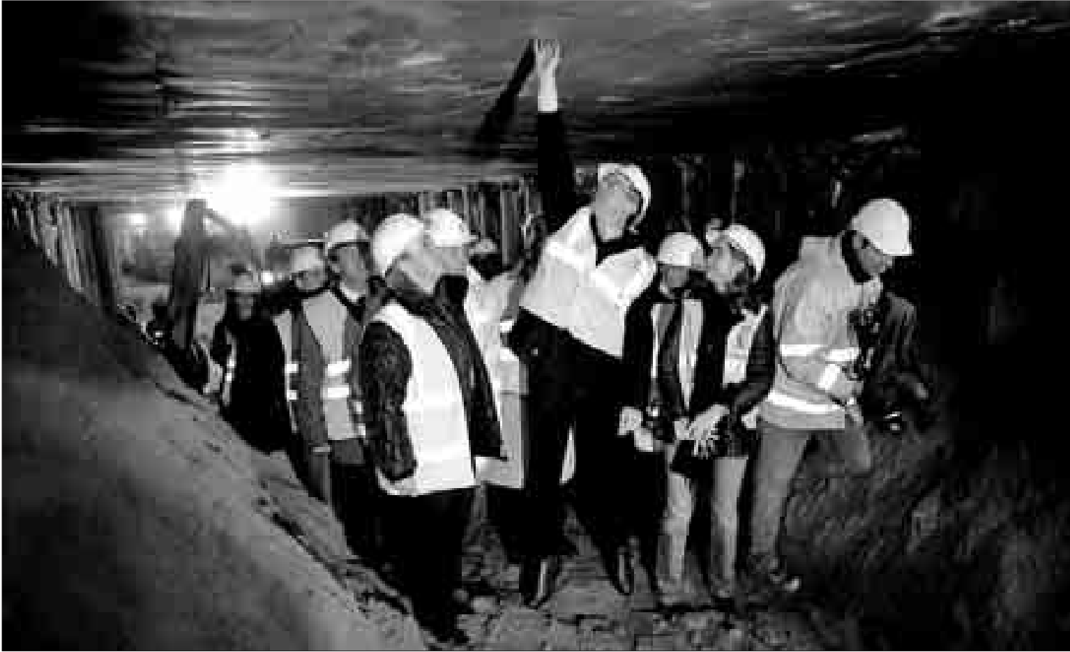
Alberto Ruiz-Gallardón toca, ayer, el techo del túnel de O'Donnell tras el 'cale' del subterráneo. / CARLOS BARAJAS
