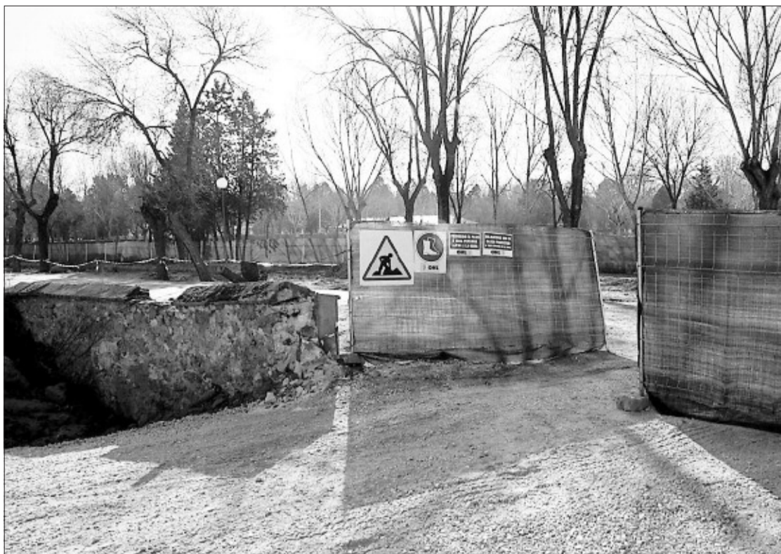
Uno de los boquetes abiertos en el muro de la Casa de Campo para permitir el paso de camiones. / GORKA LEJARCEGI
