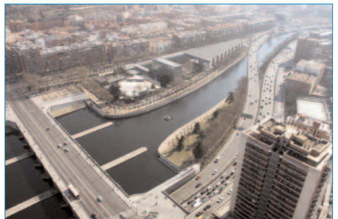
Situación de la M-30 en el entorno del Puente de Segovia antes del inicio de las obras.
