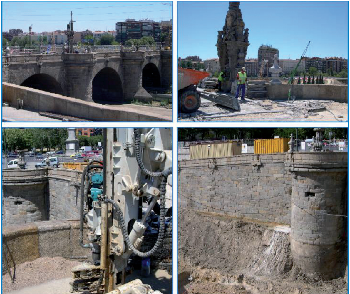
Trabajos de consolidación.
