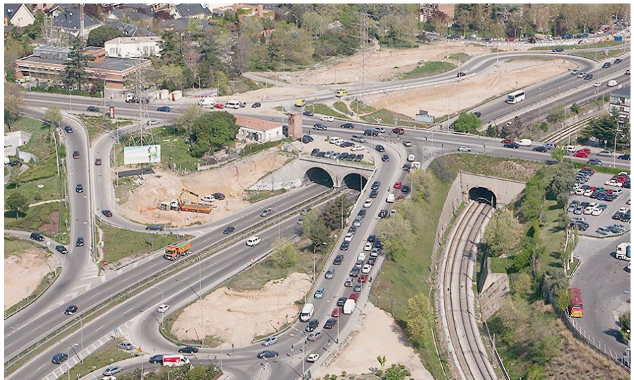
Puente de la avenida del Cardenal Herrera Oria y trazado de la carretera de Colmenar, antes de las obras.
