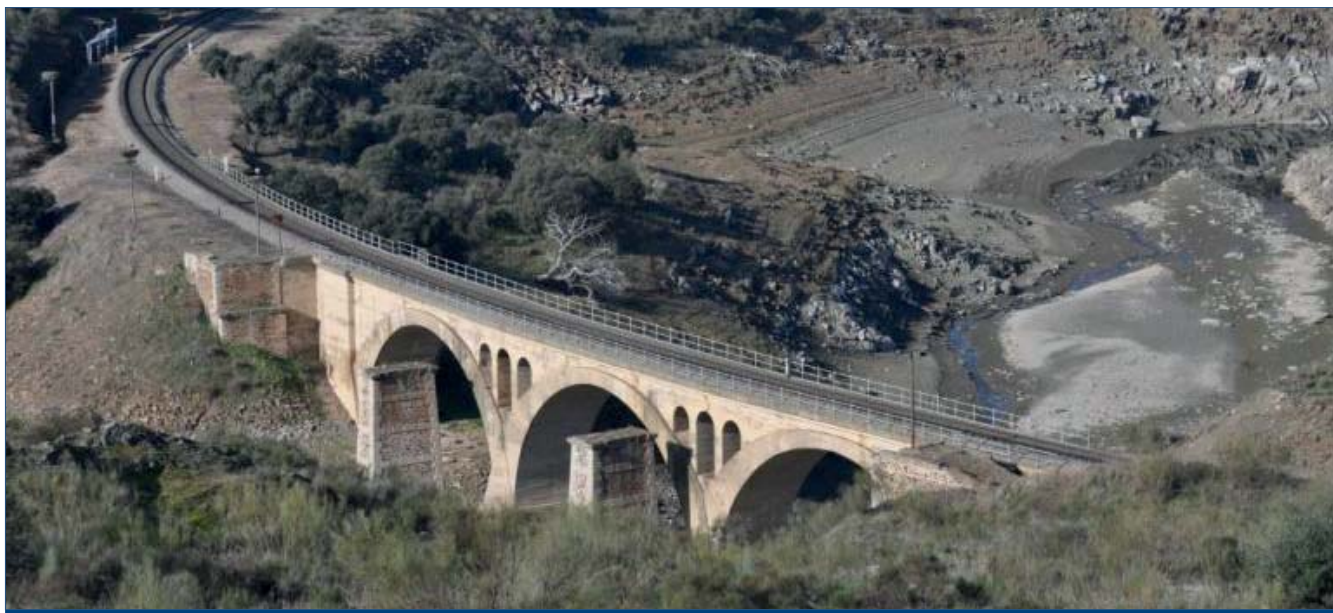
Figura 4. Puente del ferrocarril sobre el arroyo Villoluengo
