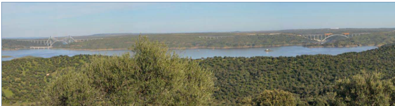
Figura 10. Puentes del Ave Madrid-Extremadura. A la izquierda sobre el río Tajo; a la derecha sobre el río Almonte"
